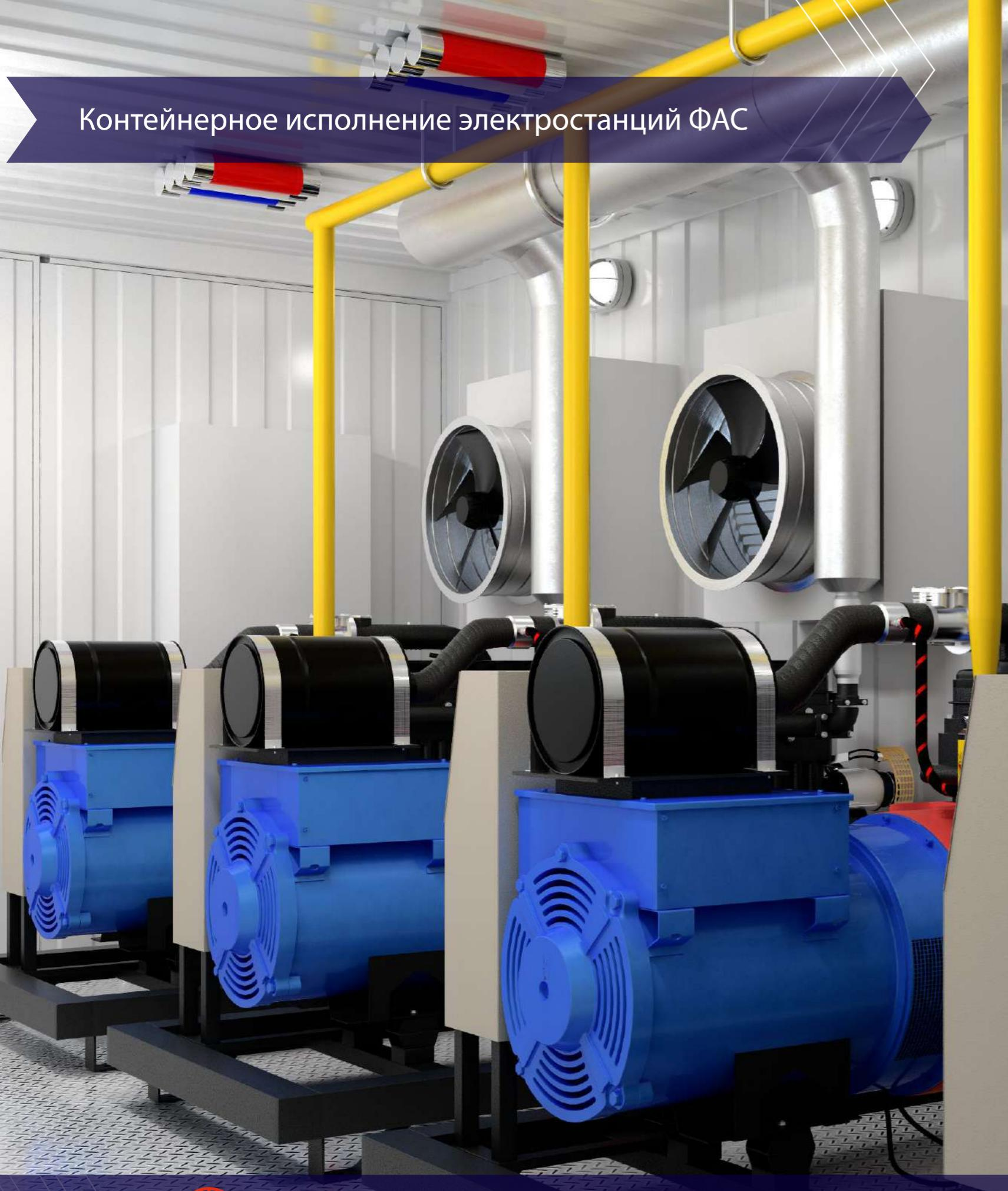
Для обеспечения мобильности и надёжной работы ГПЭС ФАС в суровых климатических условиях и на открытых площадках мы предлагаем контейнерное размещение оборудования для нормального функционирования как в ручном, так и в автоматическом режимах.
